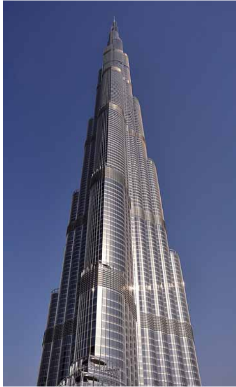
Figur 0.3: Med sine 828 meter fordelt på 162 etager er Burj Khalifa i Dubai verdens højeste bygning og samtidig en af planetens mest imponerende konstruktioner. Grundet risikoen for salt fra havet er store dele af bygningen lavet af syrefast, rustfrit stål af typen 4404.
